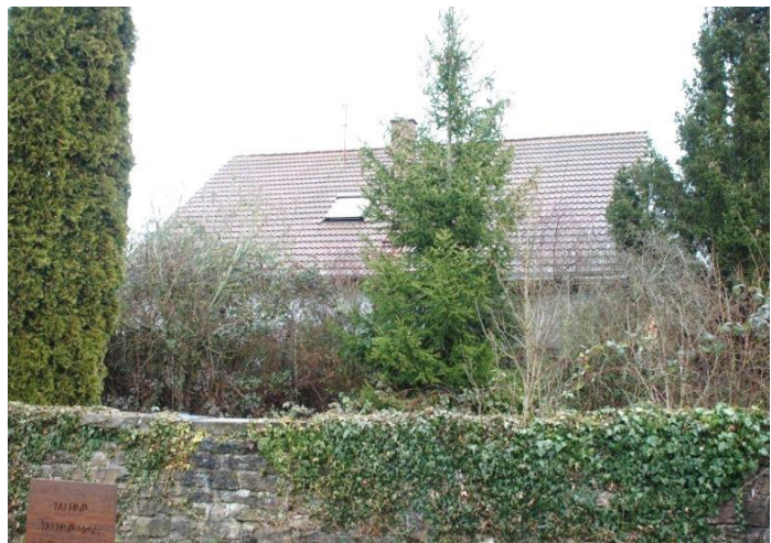
(3) Ansicht West vom Friedhof Garten verwildert bis zur Hauskante
