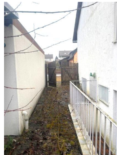
(9) Durchgang zwischen Haus und Garagen auf der Nordseite
