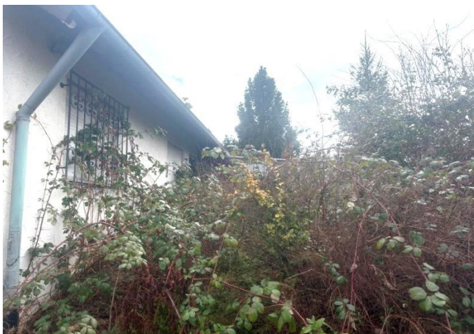
(4) Detail vor Westfassade; Dornen bis zur Haus- außenwand und über die Terrasse im Westen
