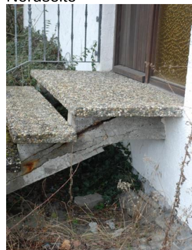
(11) Detail Treppe vor Haus- eingang
